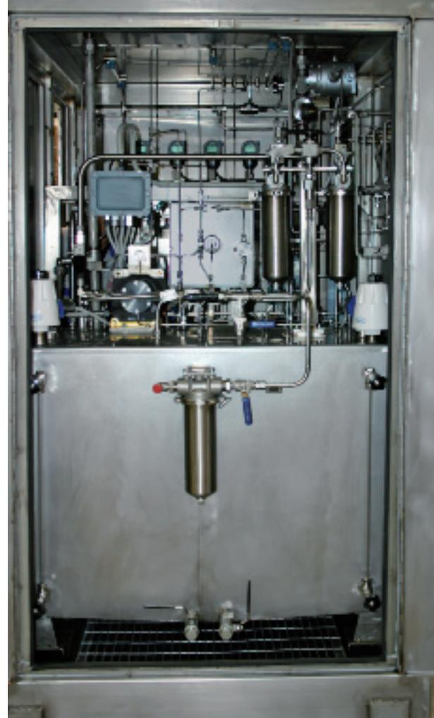
**Fig. 8 – Installata su una piattaforma petrolifera, la funzione di questa Hpu (Hydraulic Power Unit) è quella di azionare un attuatore idraulico montato su di una valvola sottomarina posta a 90 m di profondità.**
